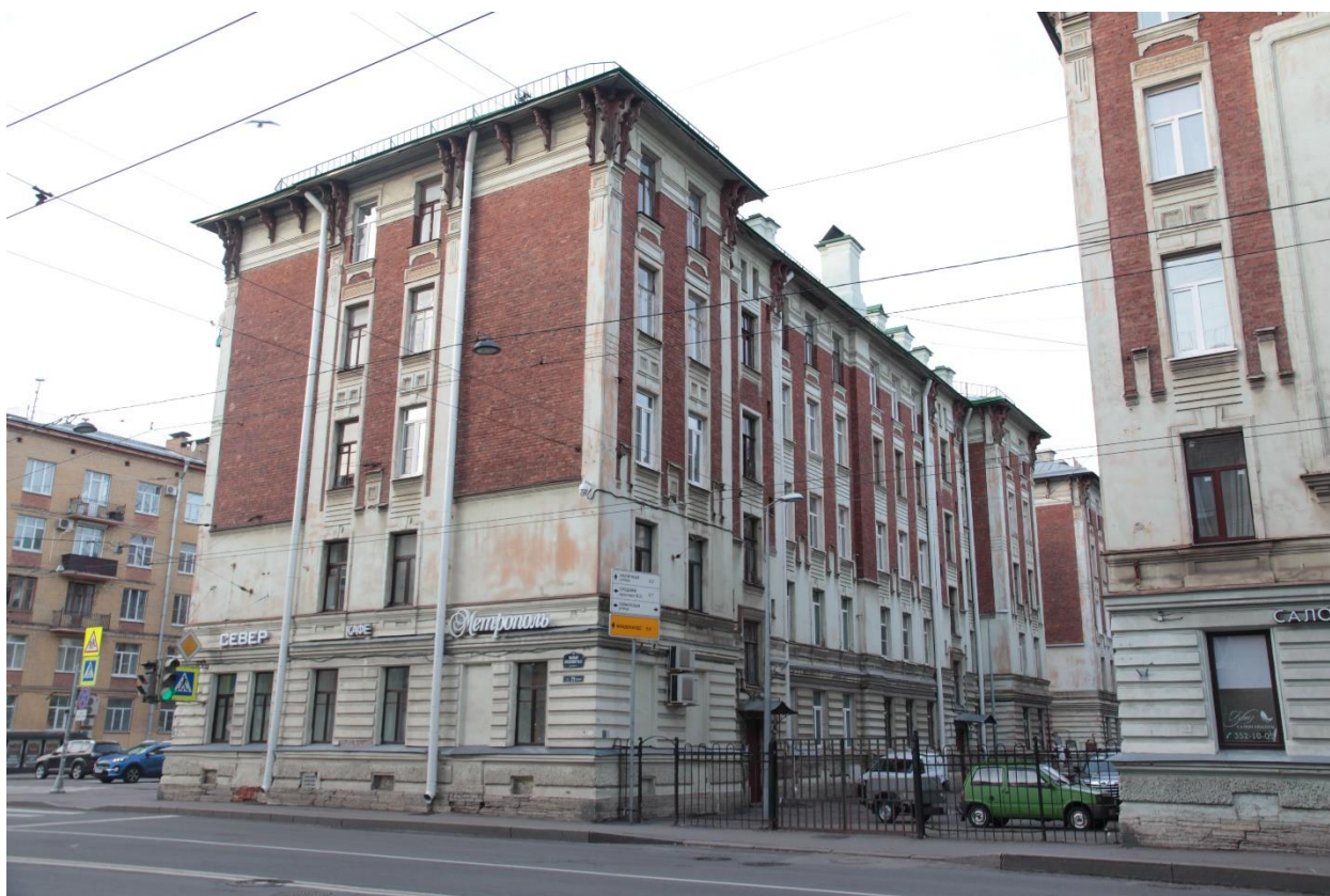
Рис. 2. Гаванский рабочий городок. Корпус на пересечении Малого проспекта Васильевского острова и Гаванской улицы.
